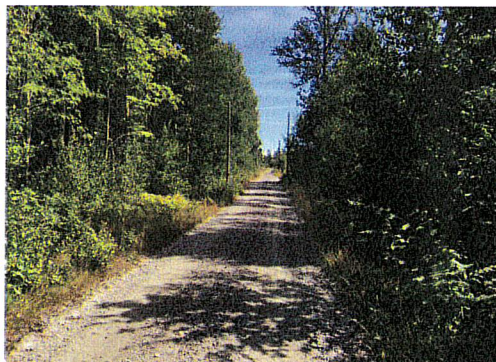
Befintlig infartsväg till Lekevallen.
